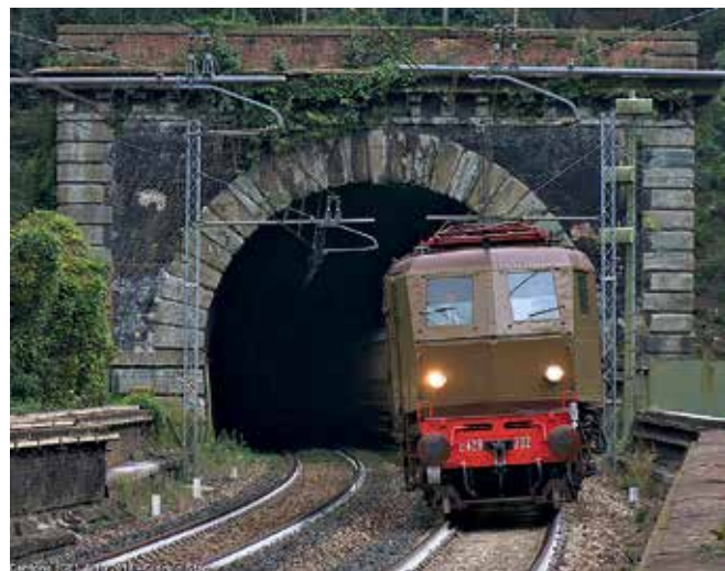
Severní portál tunelu Creverina na trati do Janova
