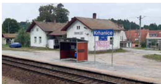
Železniční zastávka Krhanice
