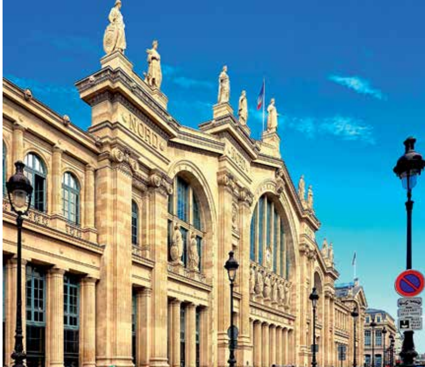
Centrální část monumentální fasády nádraží Paris-Nord
