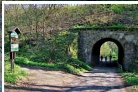
Tunel pod tratí Švestkové dráhy do Oparenského údolí
